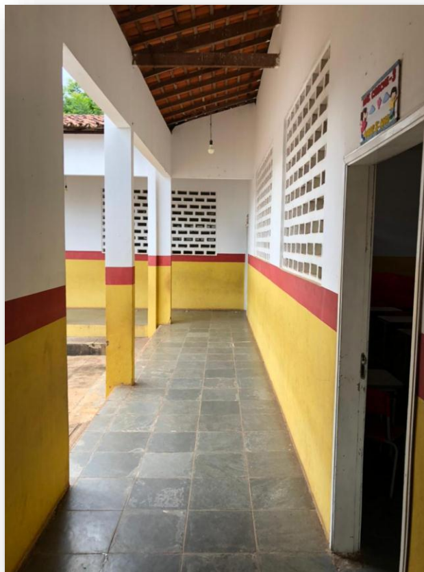
Piso antigo a Substituir, paredes a revestir com cerâmica até 1m.
