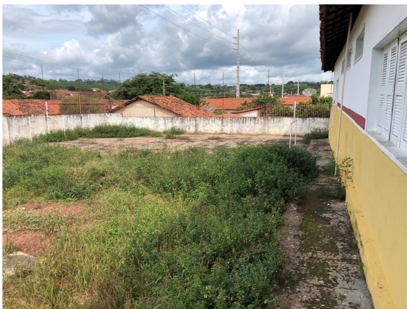
Quadra externa a recuperar o piso.
