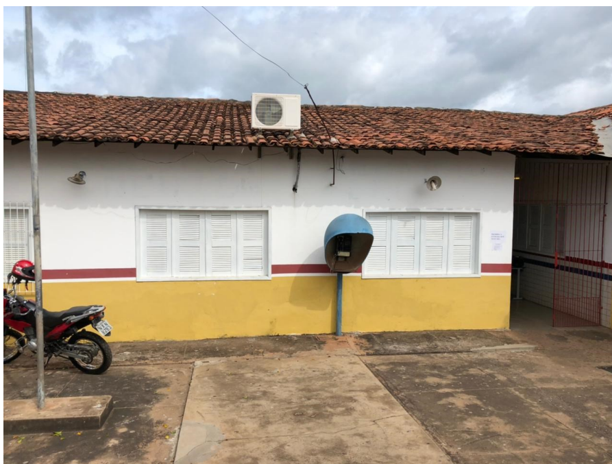
Fachada – Substituir Janela e executar Cerâmica em paredes até 1m.
