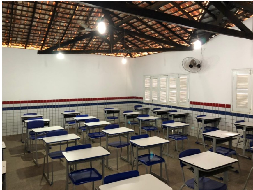
Sala de Aula – Forrar e Substituir Janelas
